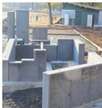
In die Blechhülsen wurden dann die Betonanker verschraubt.
