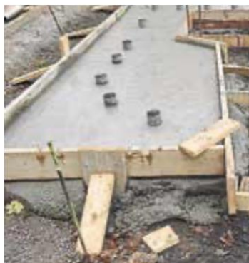
Das Einsetzen der Blechhülsen in schnellhärtenden Beton.
